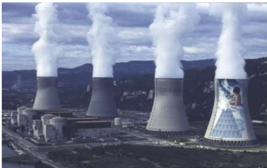
Centrale nucléaire de production d'électricité de Cruas-Meyssac, en Ardèche (source : http://erivel.club.fr/index.htm )
